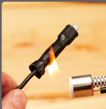
Оптимальный диапазон нагрева составляет +90°C...+125°C.
